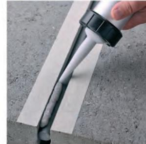
Pro ochranu okolních ploch před potřsněním je vhodné použít Maskovací krepovou pásku. Podle šířky tmelené spáry vyberte provazec větší asi o 25% a vtláčte jej do spáry (viz. tabulka). Stejně hloubky umístění provazce lze docilit pomocí jednoduchého přípravku – dřevěného kolíku s ryskou.
