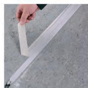
Po plném vyplnění spáry se tmel stáhne pomocí špachtle nebo silikonové stérky a vyhladí pomocí Vyhlazovacího roztoku Finisher.
